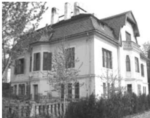
A Blaha utcai épület a felújítás előtt
